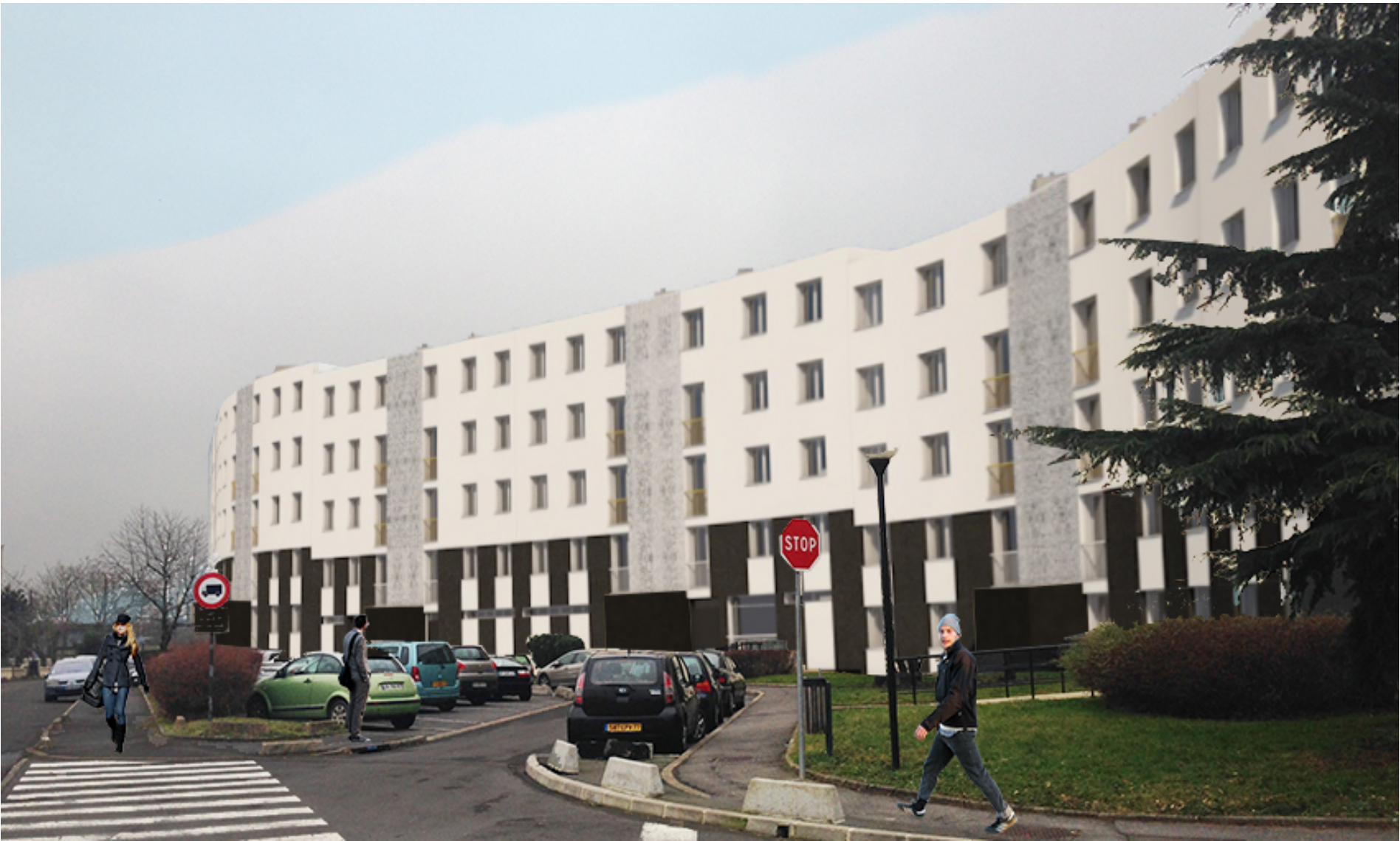
Vue depuis l'angle Est de la rue des Soldats de la Marne
